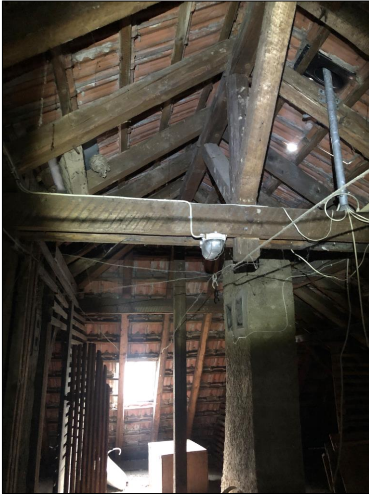
Abbildung 9: Dachboden mit Holzkonstruktion und ungedämmter Ziegeleindeckung
