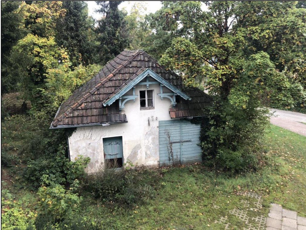
Abbildung 17: Südansicht des Nebengebäudes
