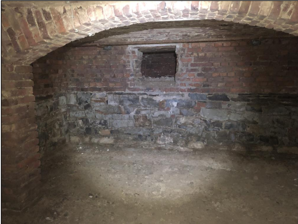
Abbildung 11: Beispiel eines Kellerraumes mit sich anschließender höhergelegenen Raumebene
