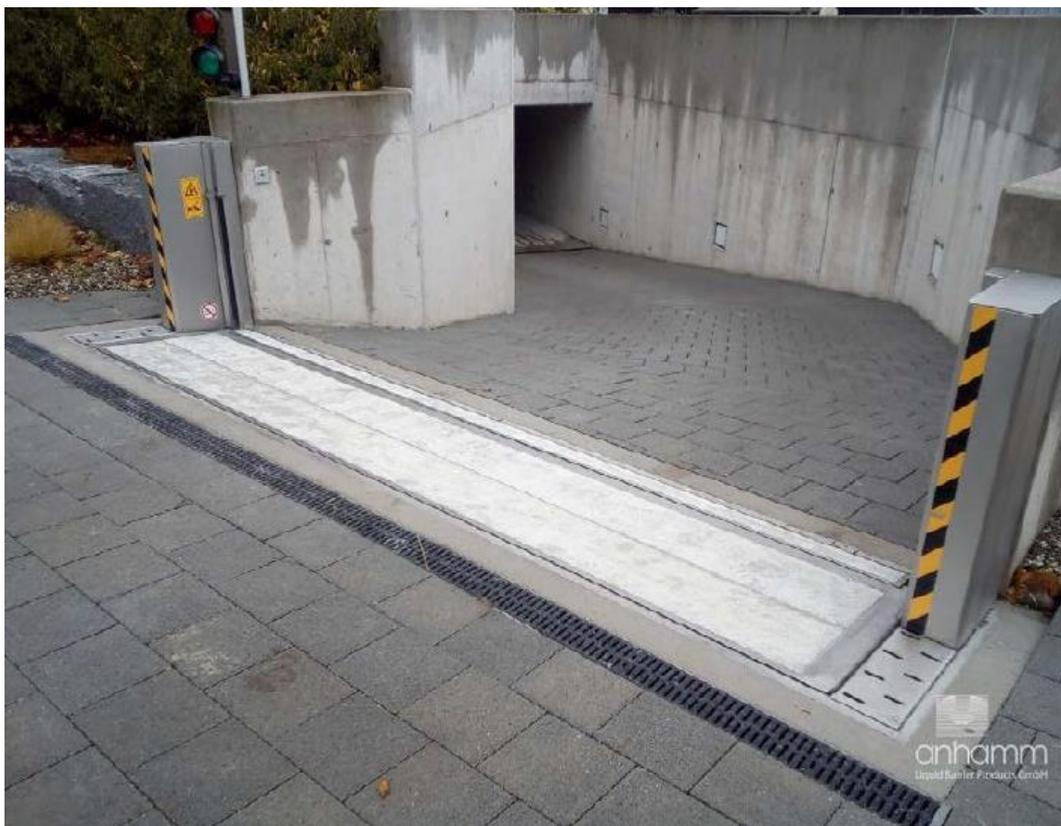
Abbildung Nr. 9 – Muster eines Klappschotts an einer Tiefgarageneinfahrt
