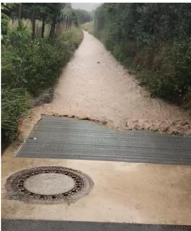
Abbildung 5: Muster des Einlaufbauwerk Vehner Weg während des Starkregenereignis vom 11.06.2018
