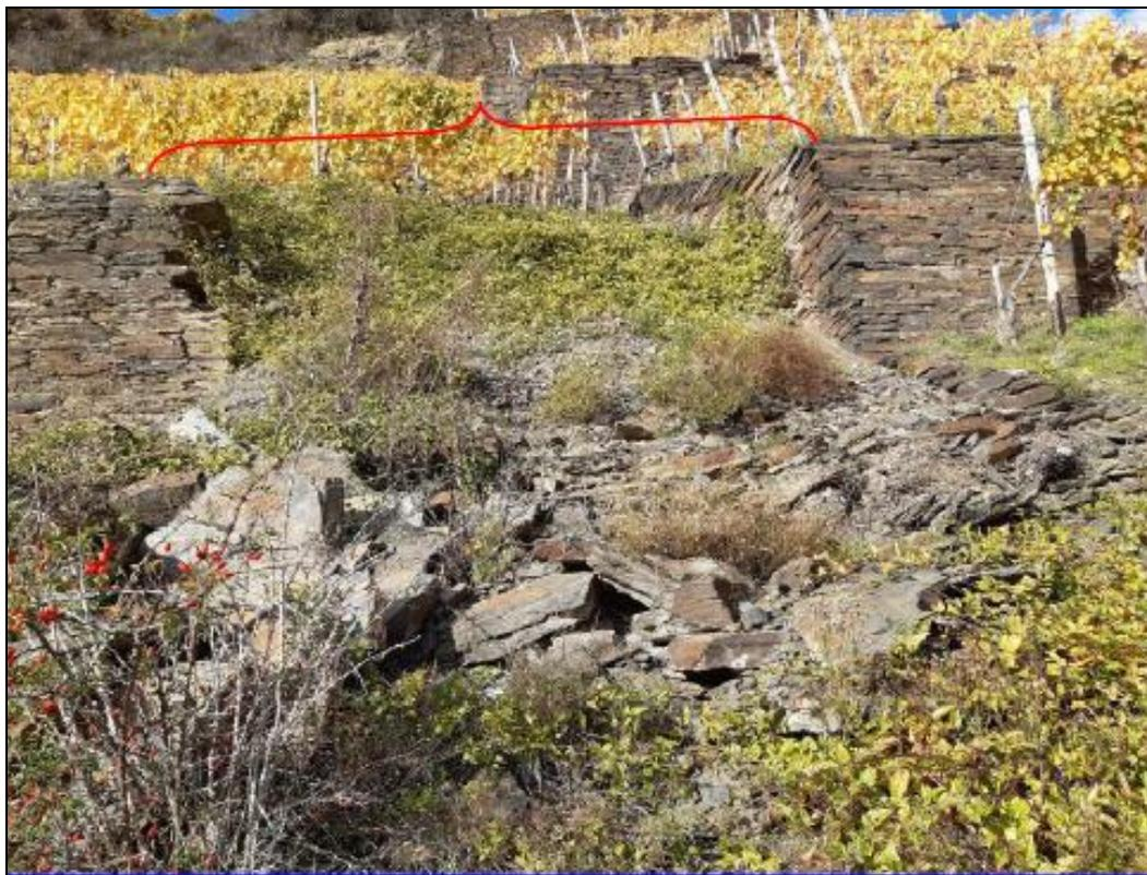
Abb. 4: Eingebrochene Trockenmauer (DLR 2020)
