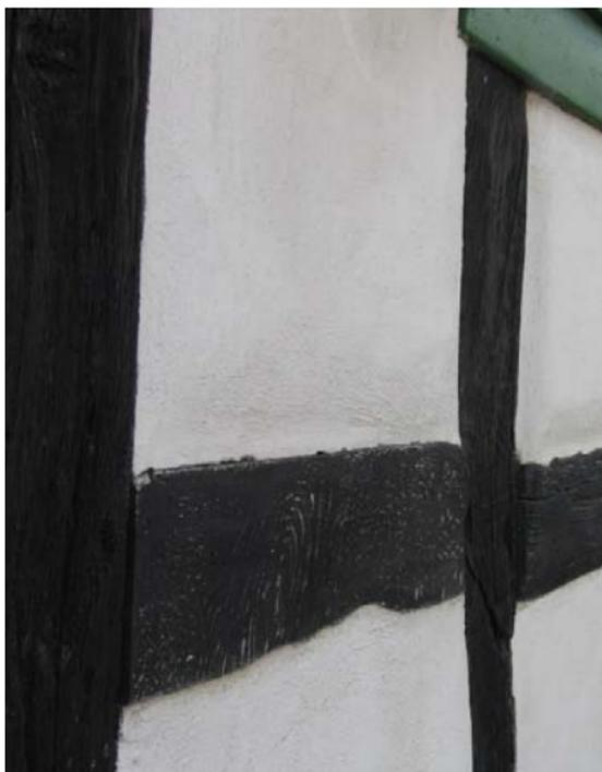
**Machen Sie es richtig!** - Der Übergang von Gefach zu Holzkonstruktion ist hier gelungen. Das Wasser fließt bei Regen einfach ab.
